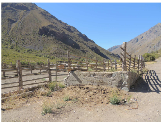
Fotografía 17 Cargadero de ganado y corrales de Cruz de Piedra. 2014
